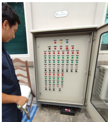
ภาพที่ 3-11 แยกมิเตอร์แผงควบคุมระบบบำบัดน้ำเสียโดยเฉพาะ
