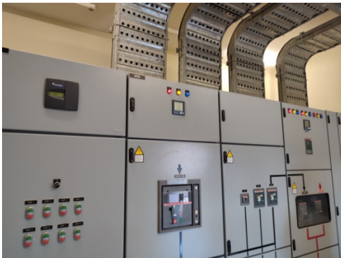
ภาพที่ 3-31 ห้องไฟฟ้าประจำอาคาร และป้ายเตือนหน้าห้องให้ระวังอันตรายจากไฟฟ้าช็อต
