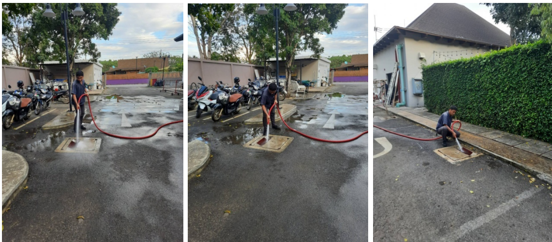
ภาพที่ 3-45 ล้างทำความสะอาดท่อระบายน้ำ ให้การระบายน้ำดี ไม่มีขยะอุดตัน
