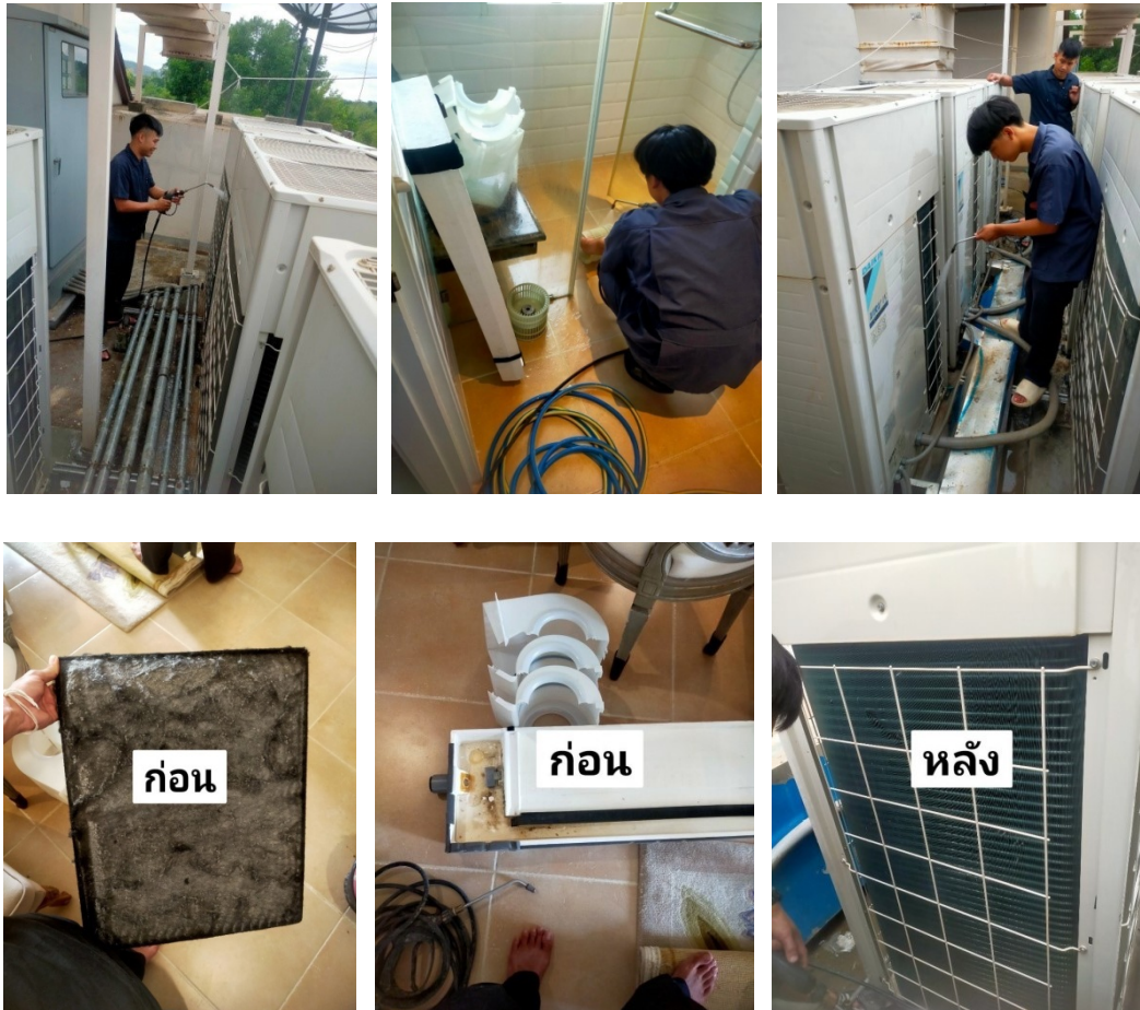
ภาพที่ 3-41 ล้างทำความสะอาดเครื่องปรับอากาศห้องพัก และเครื่องปรับอากาศห้องขยะเปียก
