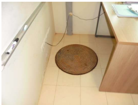
ภาพที่ 3-17 ฝาท่อส่งน้ำใต้ดิน
